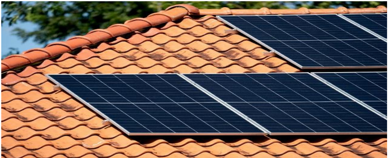
चित्र 4: एकल क्रिस्टलीय (monocrystalline) एवं बहुक्रिस्टलीय (polycrystalline) सौर पैनलों की संरचना एवं उनके व्यावहारिक अनुप्रयोग। एकल क्रिस्टलीय पैनल 22-27% तथा बहुक्रिस्टलीय पैनल 18-23% तक दक्षता प्रदान करते हैं [3]।
